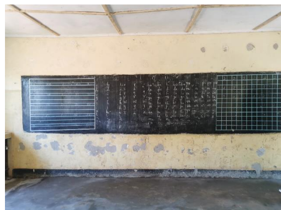
Die Wandtafel vor der Renovierung
