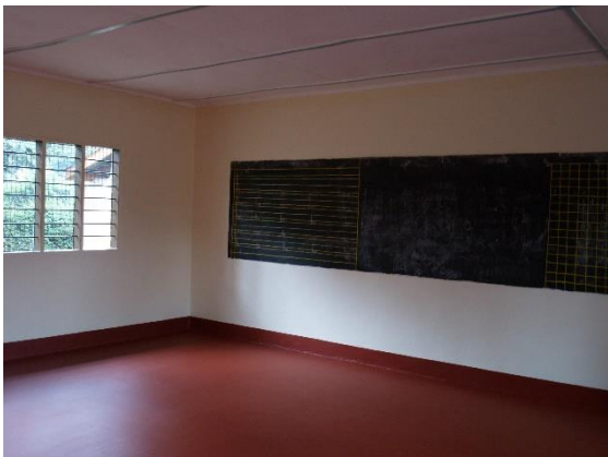
Boden und Wände erneuert
